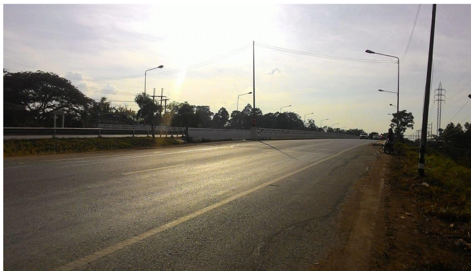
ภาพที่ 2 สะพานวัดวังหิน
