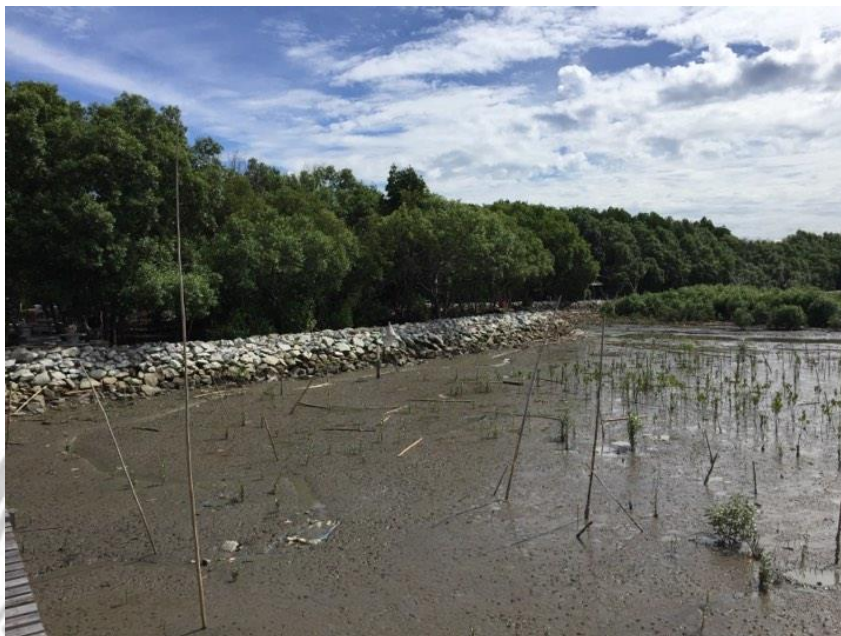
ภาพ 2.3 แนวป้องกันแบบเขื่อนหินทิ้ง บริเวณพื้นที่หมู่ที่ 10 ตำบลสองคลอง อำเภอบางปะกง จังหวัดฉะเชิงเทรา ถ่ายเมื่อวันที่ 23 สิงหาคม 2560
