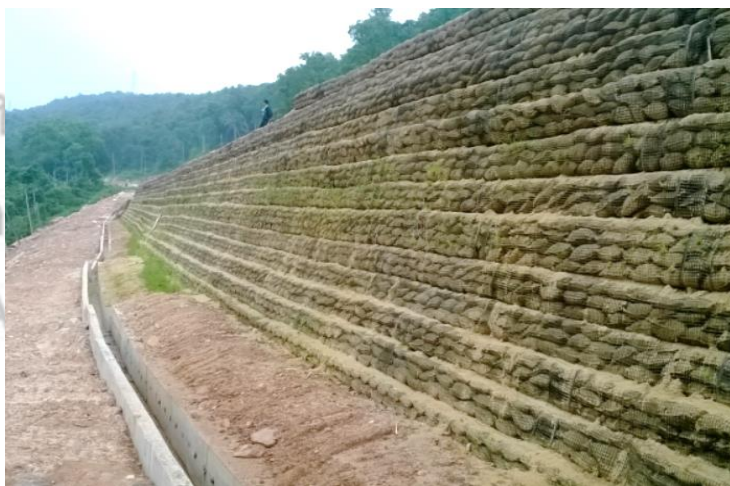
ภาพ 2.1 แสดงตาข่ายพลาสติกกันดินสไลด์ (Geogrid Embankment)
