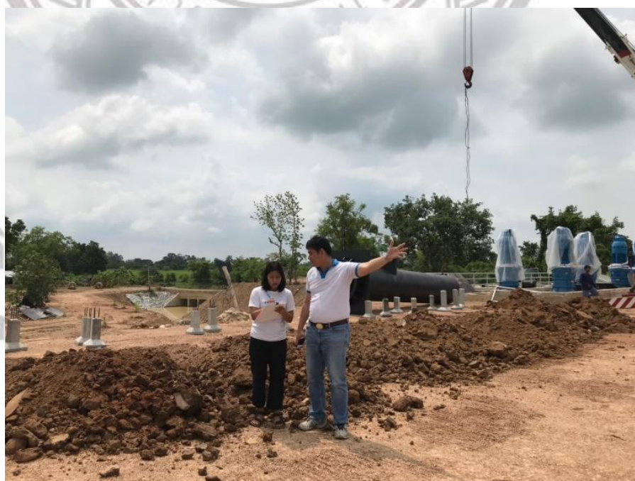
ภาพ 3.3 ลงพื้นที่เพื่อดูสถานีสูบน้ำปลายทางด้วยไฟฟ้า DR1-30L
