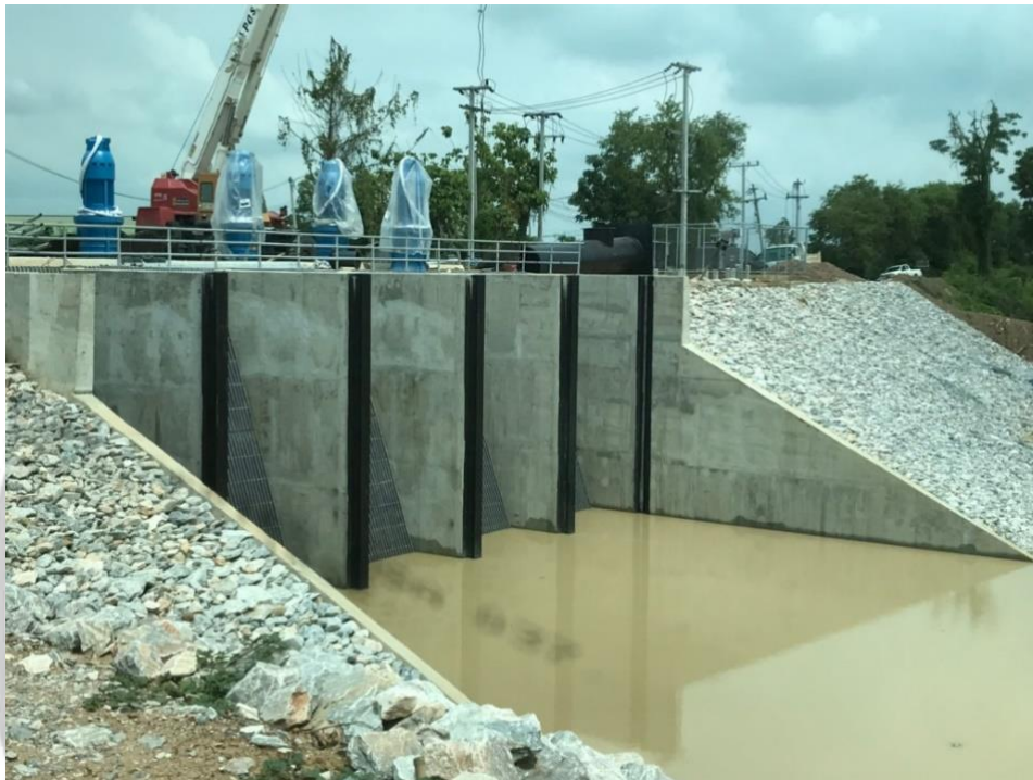
ตัวอย่างสถานีสูบน้ำปลายทางด้วยไฟฟ้า DR1-30L
