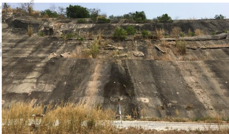
ภาพ 5.1 ทางลาดไหล่เขาทำยเขื่อนแควน้อยบำรุงแดน
