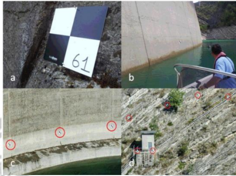
ภาพ 2.12 การวางตำแหน่งเครื่องหมาย (a) เครื่องหมายถูกนำไปวางใกล้กับรอยต่อ, (b) การประยุกต์ใช้เครื่องหมายด้านหน้าต้นน้ำ, (c) การใช้งานเครื่องหมายด้านปลายน้ำใกล้กับรากฐาน, (d) การใช้งานเครื่องหมายบนพื้นที่ที่อยู่ทางด้านซ้าย (Giuliaet et al., 2017)
