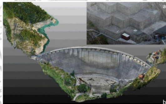
ภาพ 2.16 การตรวจสอบความหนาแน่นเชิงพื้นที่ของ Point Cloud หนาแน่น (a) Pointcloud ของบล็อกคอนกรีตทางด้านขวาที่ได้รับจาก UAV, (b) Pointcloud ของระบบเขื่อนทั้งหมดที่ได้รับจาก UAV (Giuliaet et al., 2017)
