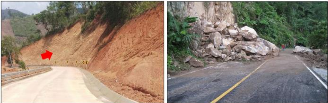
(ก) การก่อสร้างเชิงลาดด้านดินตัด (Back slope) (ข) ตัวอย่างการพังทลายของเชิงลาดด้านดินตัด/หินตัด
