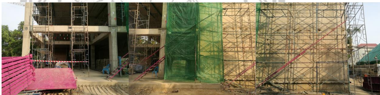
ภาพที่ 5.2 แสดงสแลน และนั่งร้านที่ตัวอาคารก่อสร้าง
