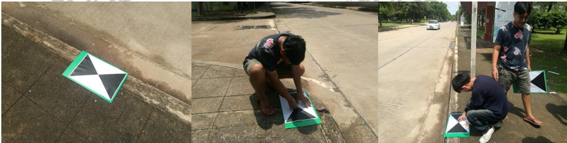
ภาพที่ 4.1 แสดงการวางจุด GCPs ในจุดต่าง ๆ
