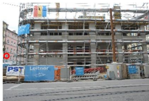
ภาพที่ 2.7 ตัวอย่างสำหรับสองภาพที่ถ่ายในสถานที่ก่อสร้าง ซึ่งวงกลมสีแดงจะแสดงจุดควบคุม (Braun et al. ,
