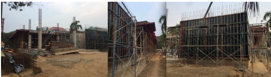
ภาพที่ 5.1 แสดงสภาพแวดล้อมของอาคารก่อสร้าง
