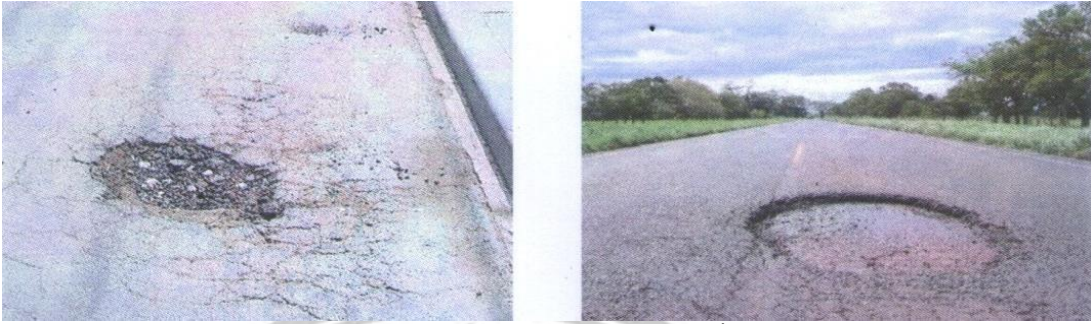
ภาพที่ 2.1 ความเสียหายประเภทหลุมบนพื้นถนน (สำนักงานวิเคราะห์และตรวจสอบและสำนักงานบริหารบำรุงทาง 2550)
