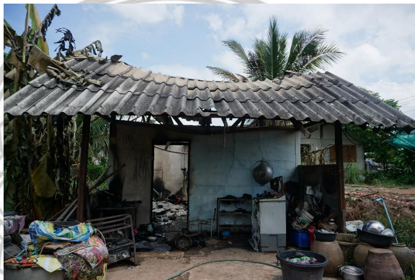
ภาพ 4.13 ภาพด้านหน้าของสถานที่เกิดเหตุเพลิงไหม้
